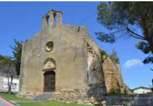
Chiesa di San Rocco Via San Rocco
