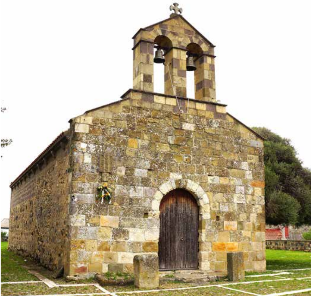
Chiesa di Santa Maria Via Santa Maria
