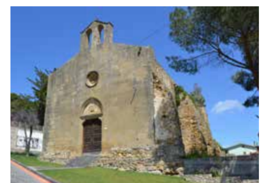
Chiesa di San Rocco 6 Via San Rocco
