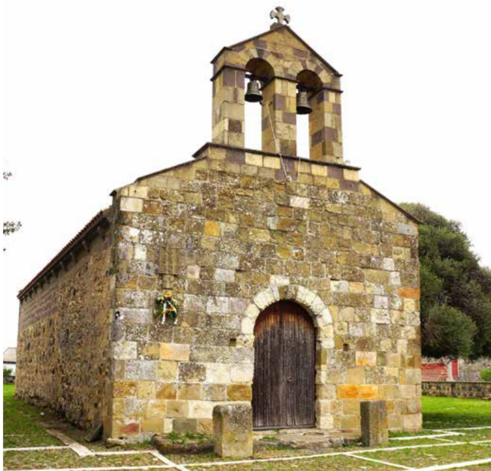
Chiesa di Santa Maria 2 Via Santa Maria
