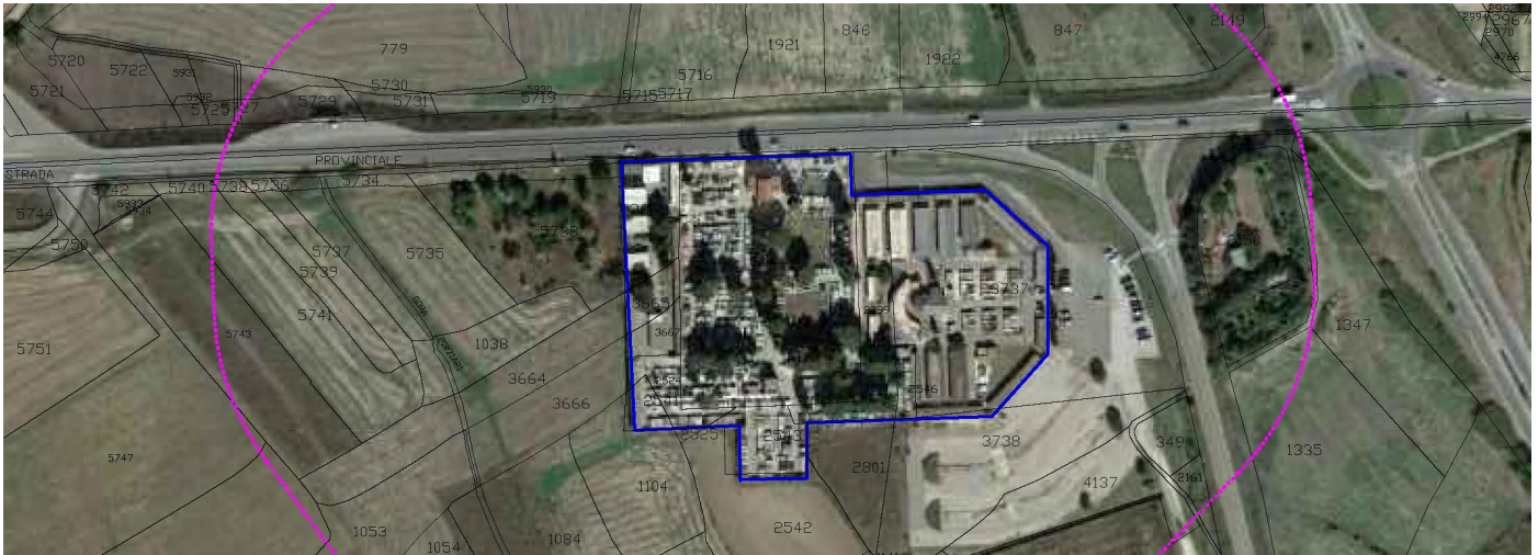
Fig. 9 Foto aerea con individuazione dell'edificato cimiteriale
