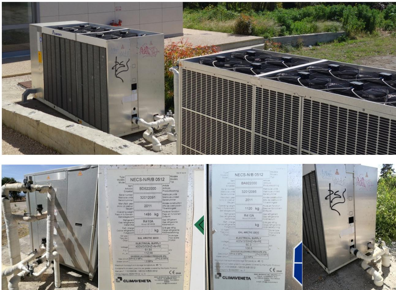
Figura 23. Pompe di calore aria/acqua invertibili ad attivazione elettrica, a servizio della struttura
