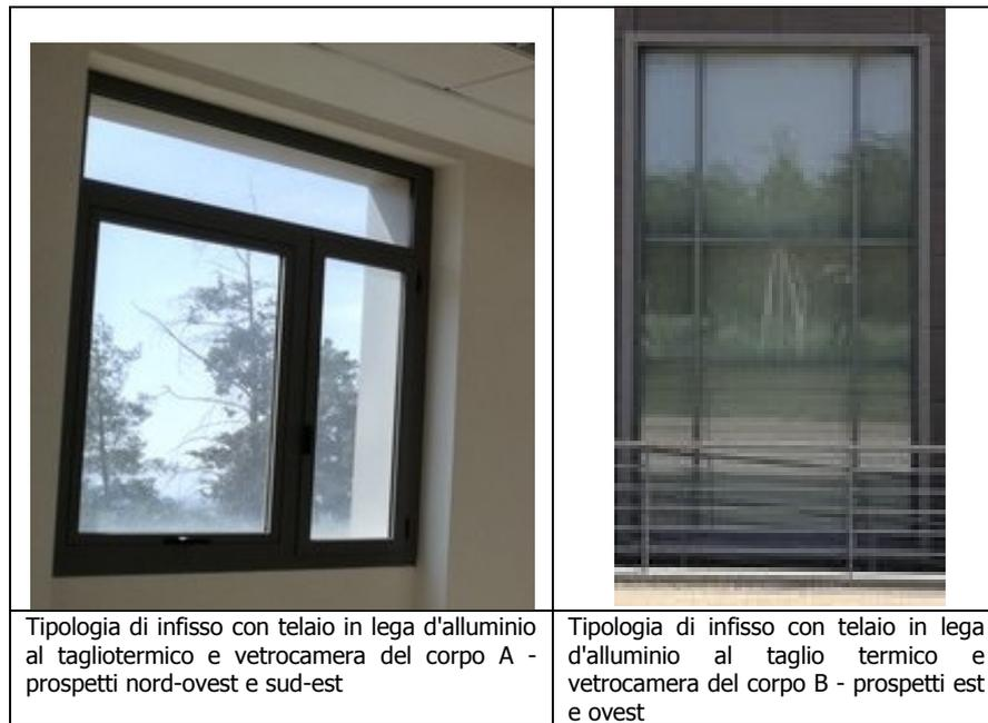
**Figura 10.** Immagine fotografica delle 2 tipologie di infisso presenti nel corpo A e nel corpo B
